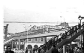
圖 2-136 民國 57 年 (1968) 3 月 6 日上午，位於北門圓環東側的臺北市第一座人行陸橋正式開放通行。(中央社記者潘月康攝)
