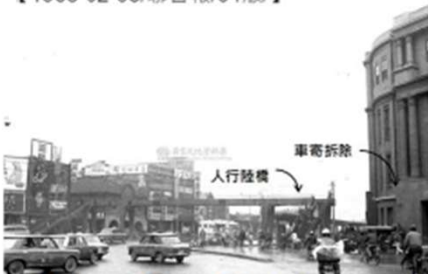
圖 2-131 民國 57 年 (1968) 配合北門圓環交通改善，拆陸橋，設地下道
